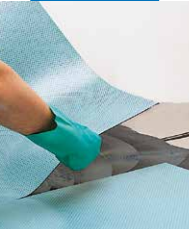
Colocación de losetas de PVC conductivo
