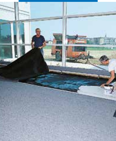
Encolado de pavimentación industrial en una empresa electrónica
