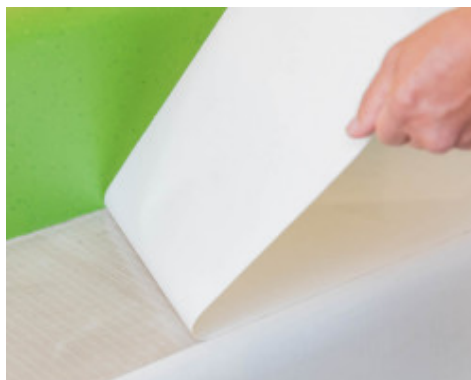
2. Retirar el papel protector de la banda de rodadura y luego de la contrahuella
