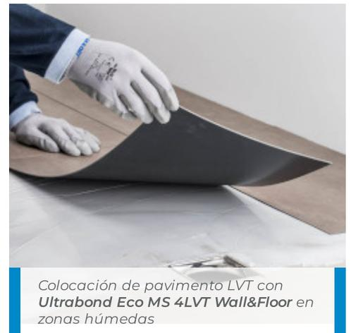
Colocación de pavimento LVT con **Ultrabond Eco MS 4LVT Wall&Floor** en zonas húmedas
