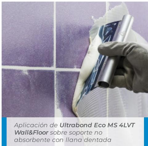
Aplicación de **Ultrabond Eco MS 4LVT Wall&Floor** sobre soporte no absorbente con llana dentada
