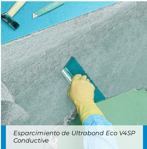
Colocación de losetas conductivas de PVC con Ultrabond Eco V4SP Conductive
