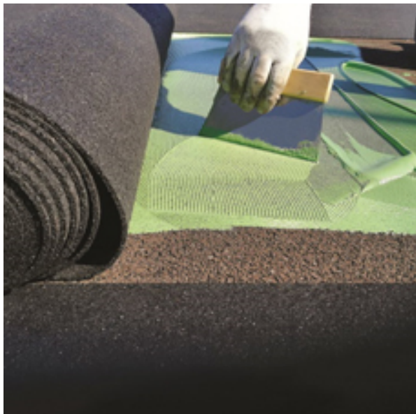
Uso de Ultrabond Turf 2 Stars Pro para la instalación de sistemas de tapetes de amortiguamiento como Mapecoat TNS Comfort
