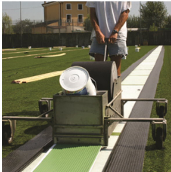
Aplicación de Ultrabond Turf 2 Stars Pro mediante un mecanismo de dosificación continua y controlada
